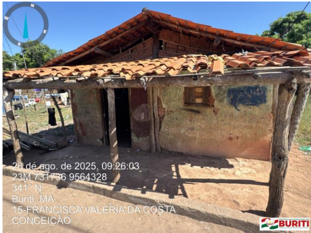
Figura 1: Foto do Terreno
