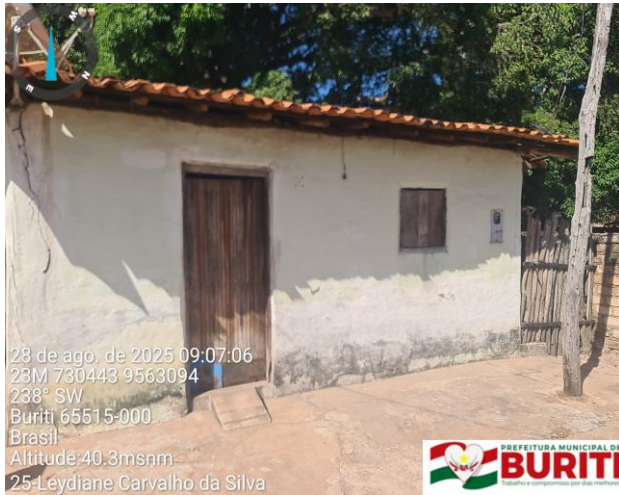
Figura 1: Foto do Terreno
