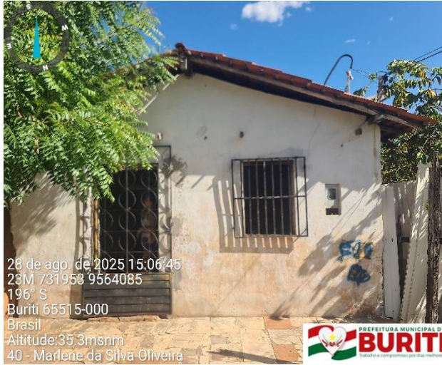
Figura 1: Foto do Terreno
