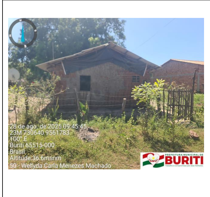
Figura 1: Foto do Terreno
