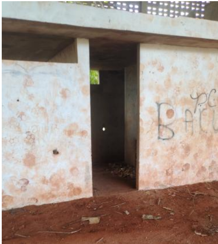
Figura 5 – Bloco dos vestiários. Fonte : Fotografia in loco, elaboração própria..
