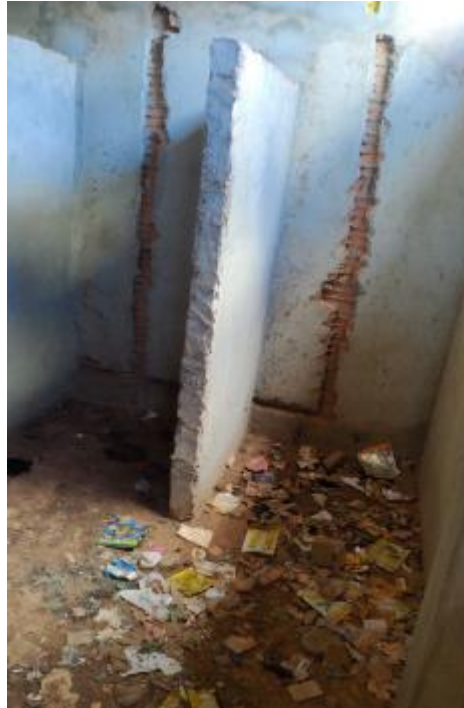
Figura 20 – Bloco dos vestiários. Fonte : Fotografia in loco, elaboração própria
