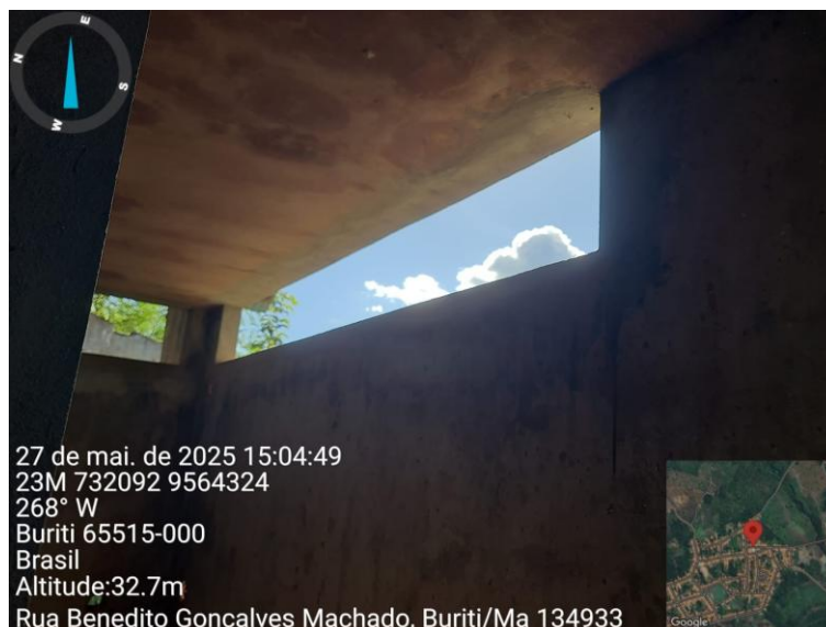
Figuras 38 e 39: Cobogó. Fonte: Fotografia in loco, elaboração própria.
