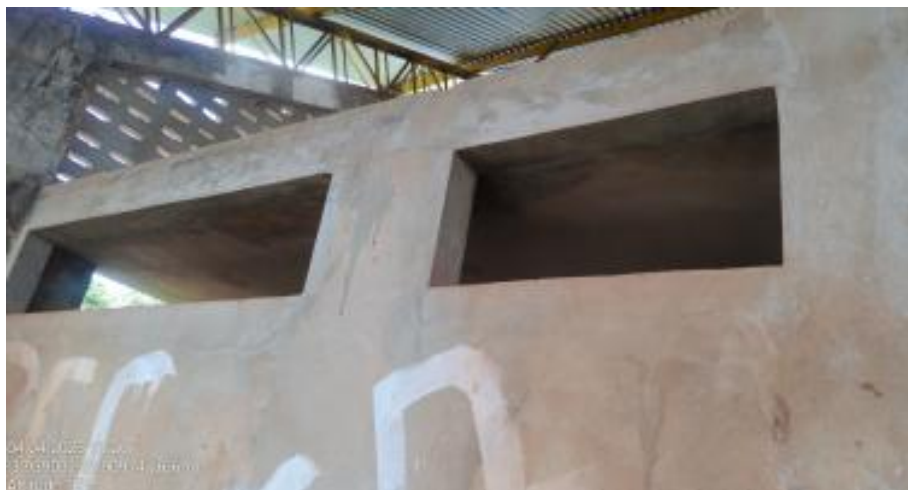
Figura 19 – Estrutura executada apenas reboco, sem pintura.. Fonte : Fotografia in loco, elaboração própria
