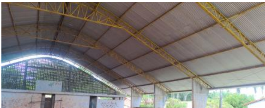
Figura 7 – Cobertura da quadra. Fonte : Fotografia in loco, elaboração própria.
