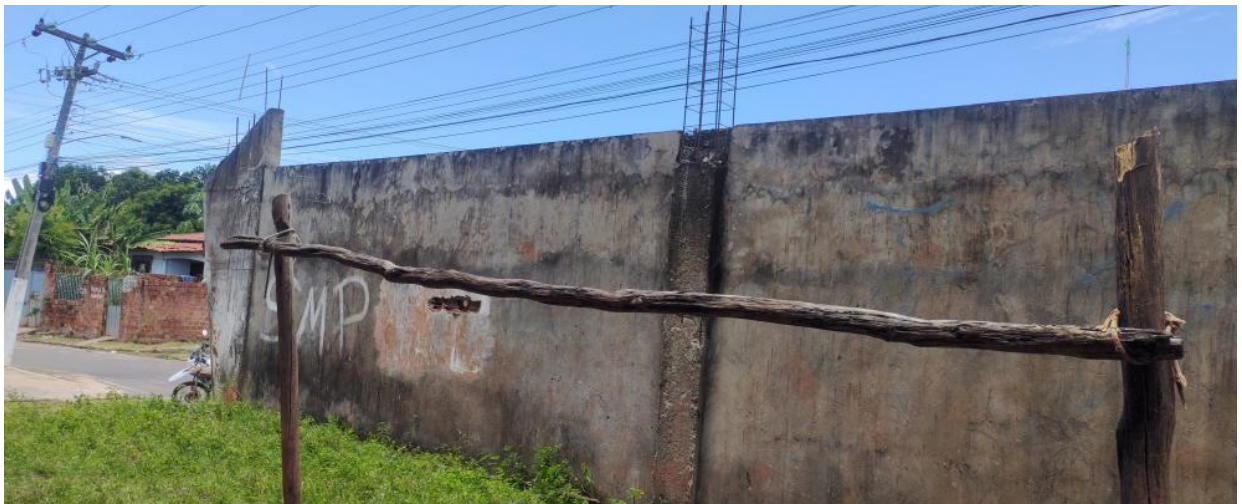
Figura 12,13 e 14 – Paredes executadas revestimento reboco. Fonte : Fotografia in loco, elaboração própria
