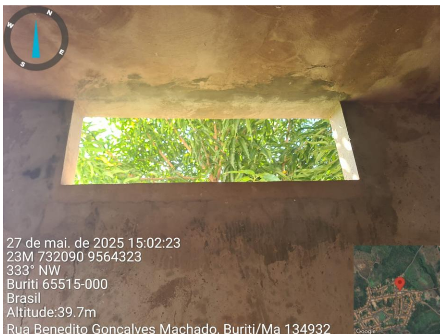
Figuras 36 e 37: Cobogó área do lavatório possui dimensão 110x50 cm, ao invés de 120x50cm.. Fonte: Fotografia in loco, elaboração própria.
