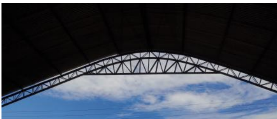
Figura 8 – Cobertura da quadra. Fonte : Fotografia in loco, elaboração própria
