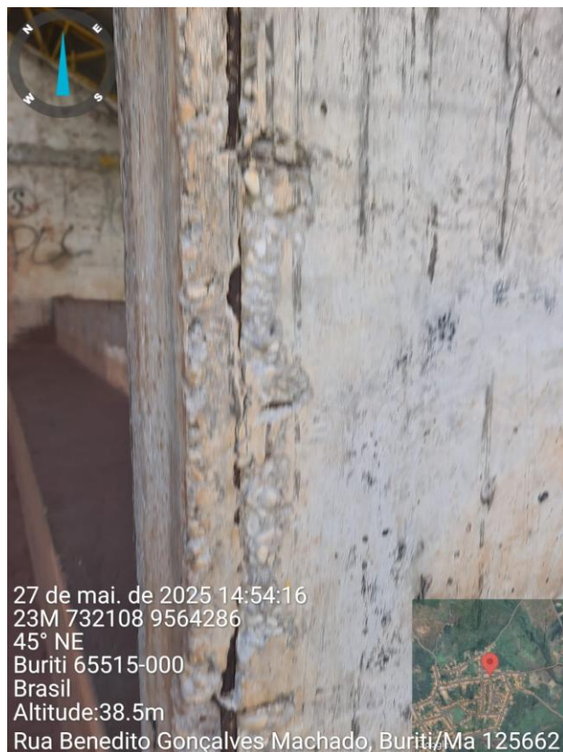
Figuras 32 e 33: Falhas de concretagem nos pilares trapezoidais. Fonte: Fotografia in loco, elaboração própria.
