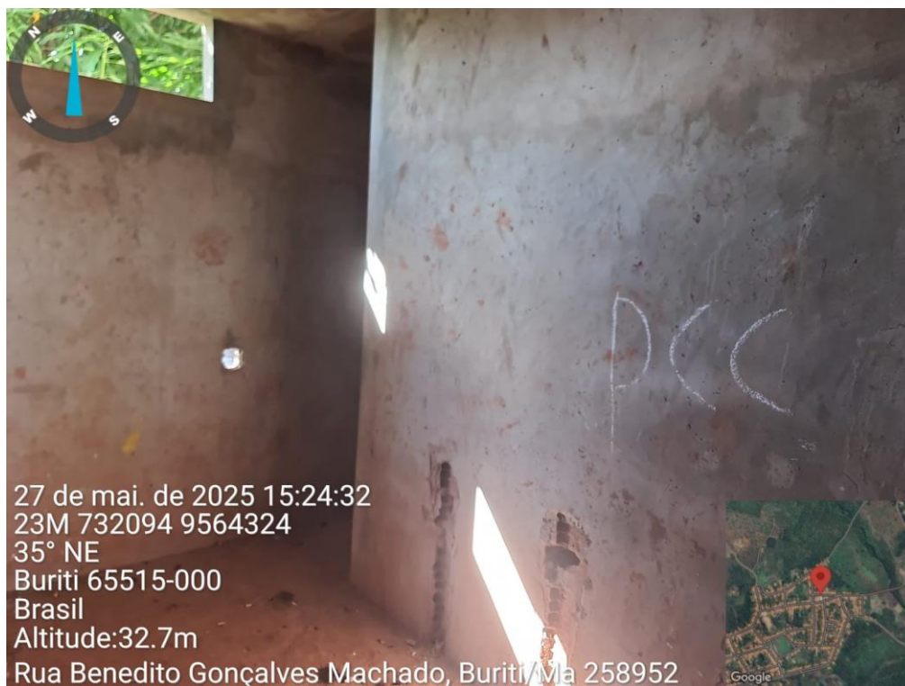
Figura 54: Vestiário. Fonte: Fotografia in loco, elaboração própria.
