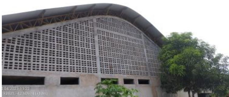
Figura 6 – Fundo da quadra. Fonte : Fotografia in loco, elaboração própria.
