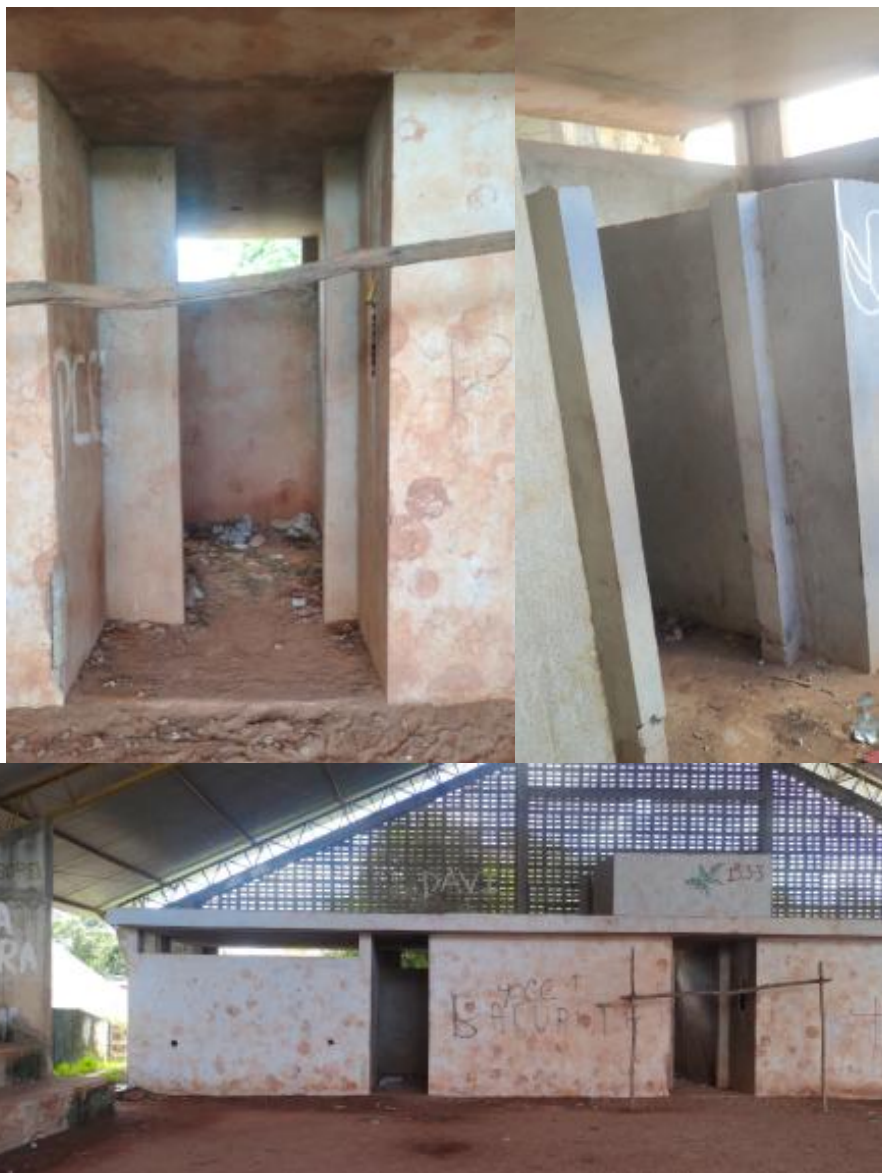
Figuras 9,10,11 – Vãos para instalação das esquadrias. Fonte : Fotografia in loco, elaboração própria.
