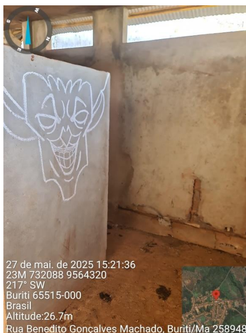
Figura 50: Vestiário. Fonte: Fotografia in loco, elaboração própria.
