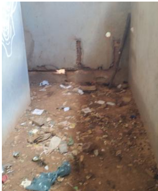
Figura 16 – Executado apenas contrapiso. Fonte : Fotografia in loco, elaboração própria
